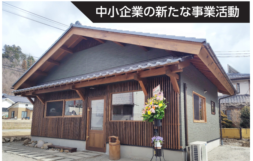
完成した新店舗
