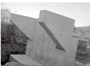
麻績川にかかる橋の基礎工事
