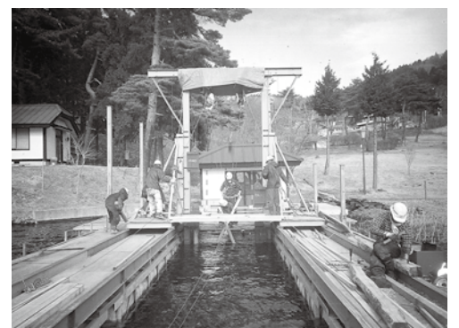
聖湖の釣り棧橋工事のための自作ドラム缶イカダ
