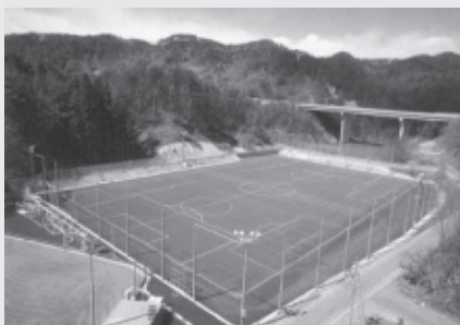
ロングパイル人工芝のサッカー場
