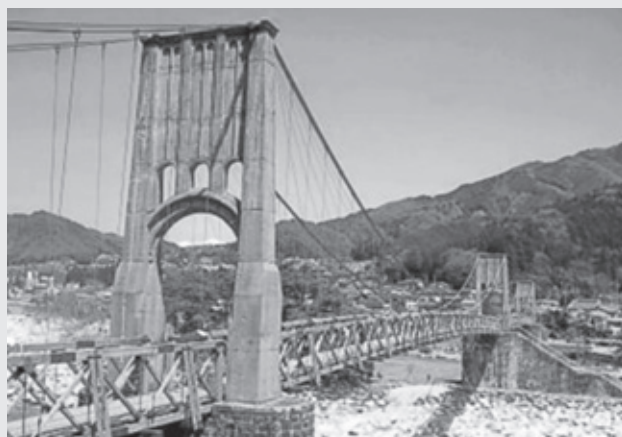
国の近代化遺産指定【桃介橋】（大正11年に架設された全長247mの木製吊橋）日本最大級の吊橋で、平成5年に修復され実際に渡ることが出来ます。
