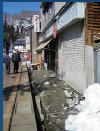
商店前道路境界の段差
