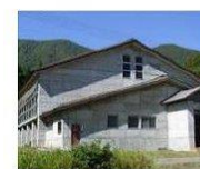
南部トレーニングセンター
