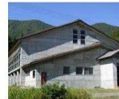
南部トレーニングセンター
