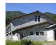
南部トレーニングセンター
