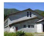
南部トレーニングセンター
