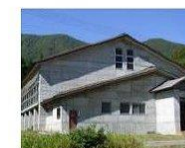
南部トレーニングセンター
