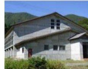
南部トレーニングセンター
