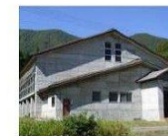
南部トレーニングセンター
